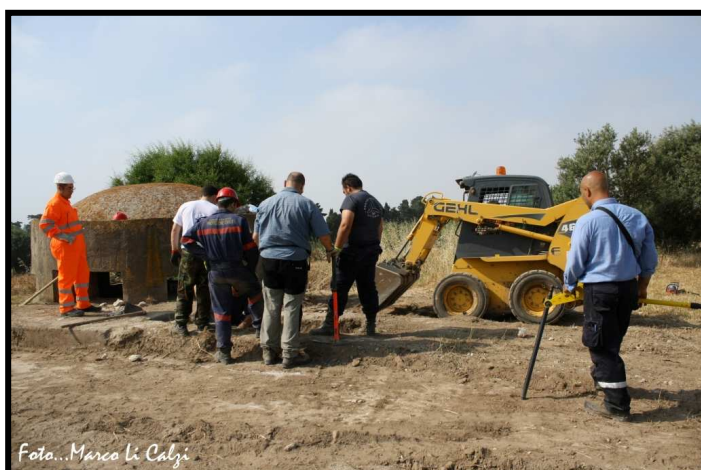
2. Un momento dei lavori
